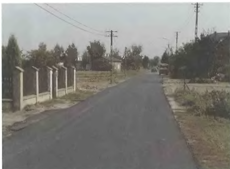
Nakładka asfaltowa na ul. Stołecznej w Płochocinie
