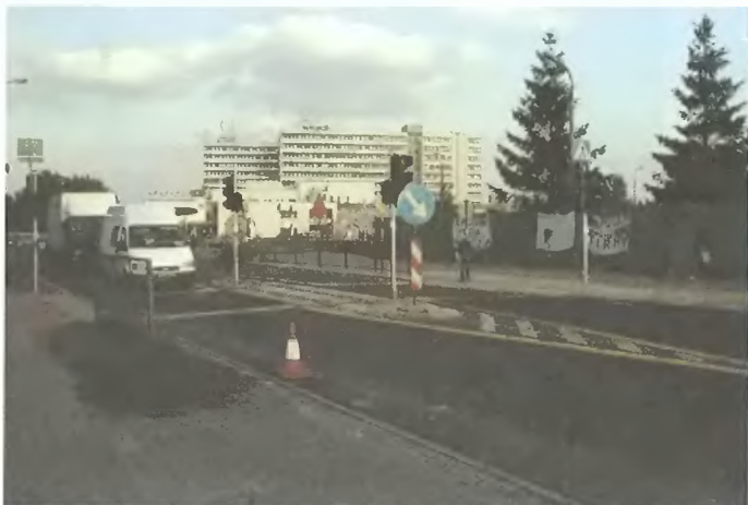
Sygnalizacja świetlna ul. Poznańska
