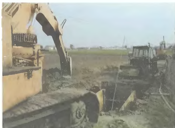
Kanalizacja w Płochocinie w trakcie robót
