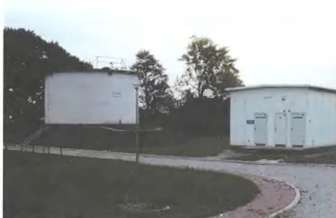
Stacja uzdatniania wody w Szeligach
