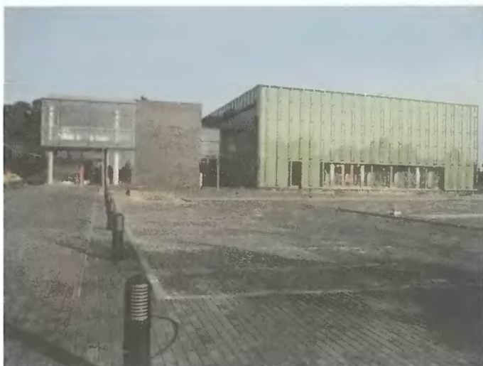
Basen - widok od strony zachodniej
