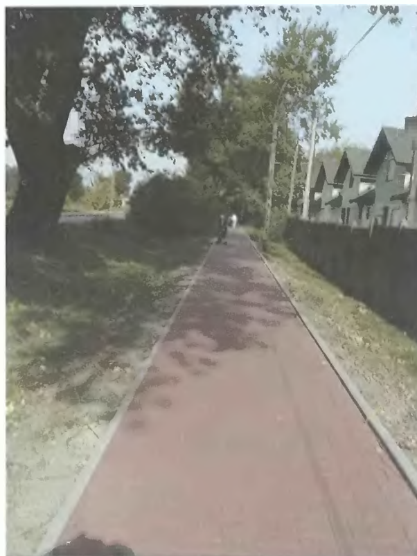
Chodnik w Płochocinie ul. Fabryczna
