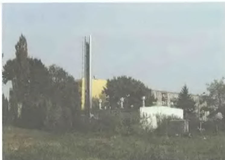
Kotłownia gazowa w Józefowie
