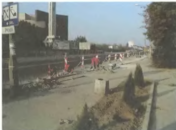
Modernizacja ul. Poznańskiej
